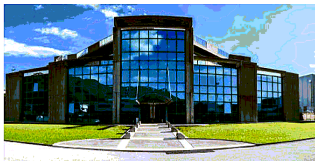
A Chiuppano la sede della Gas in concordato da due anni
